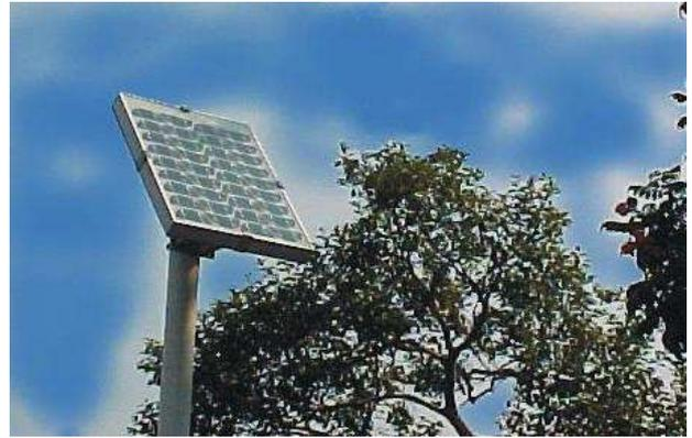
O painel solar recarrega continuamente uma bateria de 12 volts que aciona o motor do Lubrificador.
